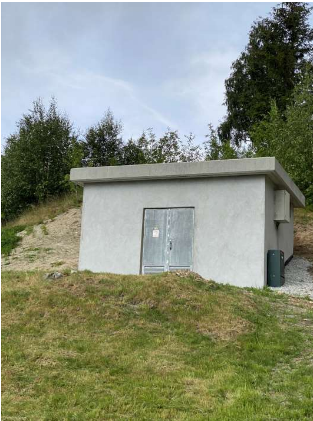
Nyoppussa nettstasjon i Røslbakkane Gaupne
