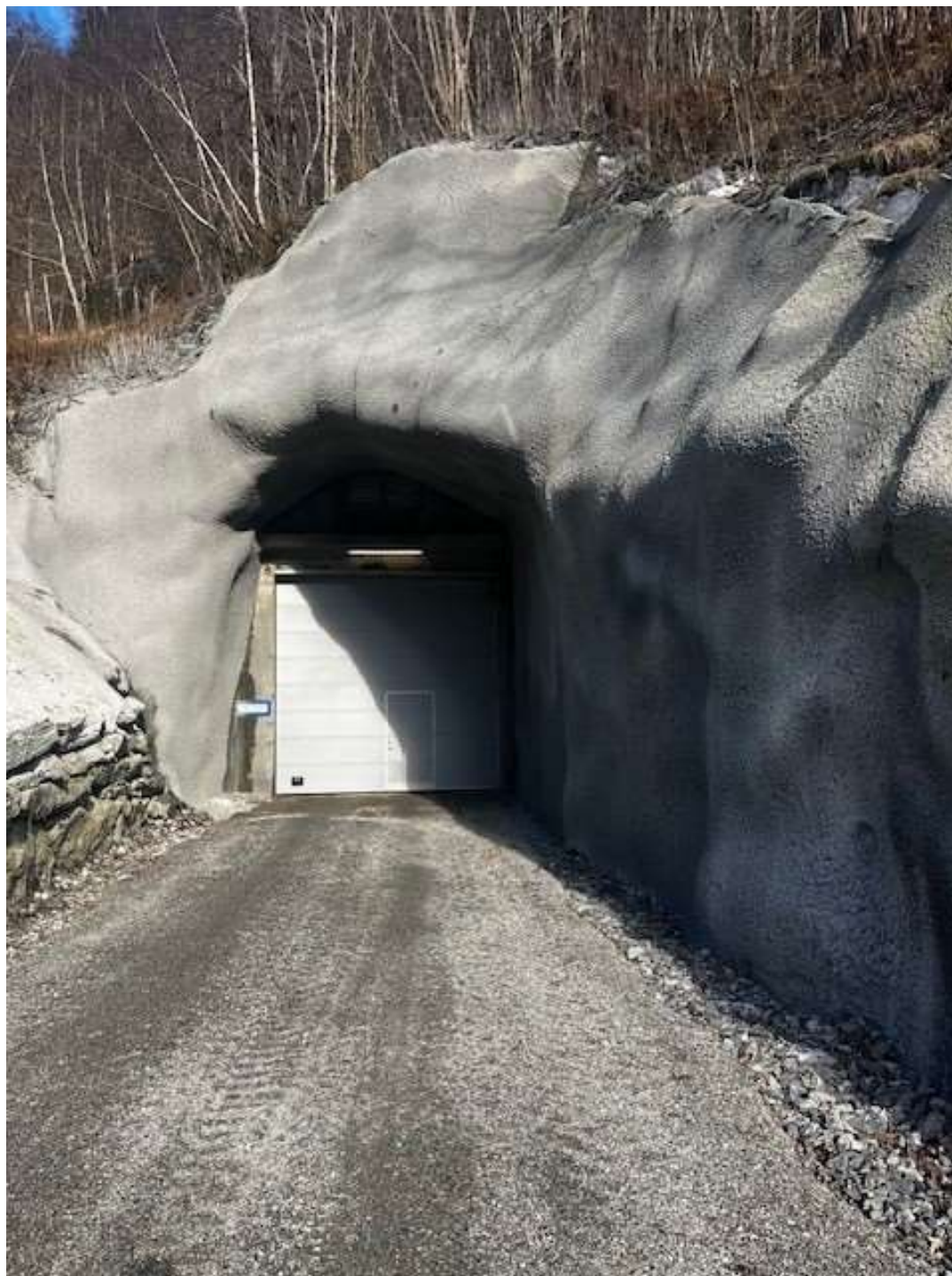
Ny portal og port på Sage Kraftverk
